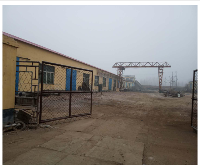
整改完毕的切割现场及料场
